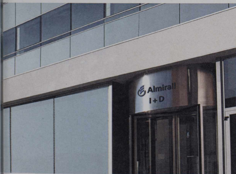
Centre de R-D d'Almirall à Sant Feliu, en banlieue de Barcelone (Espagne).
