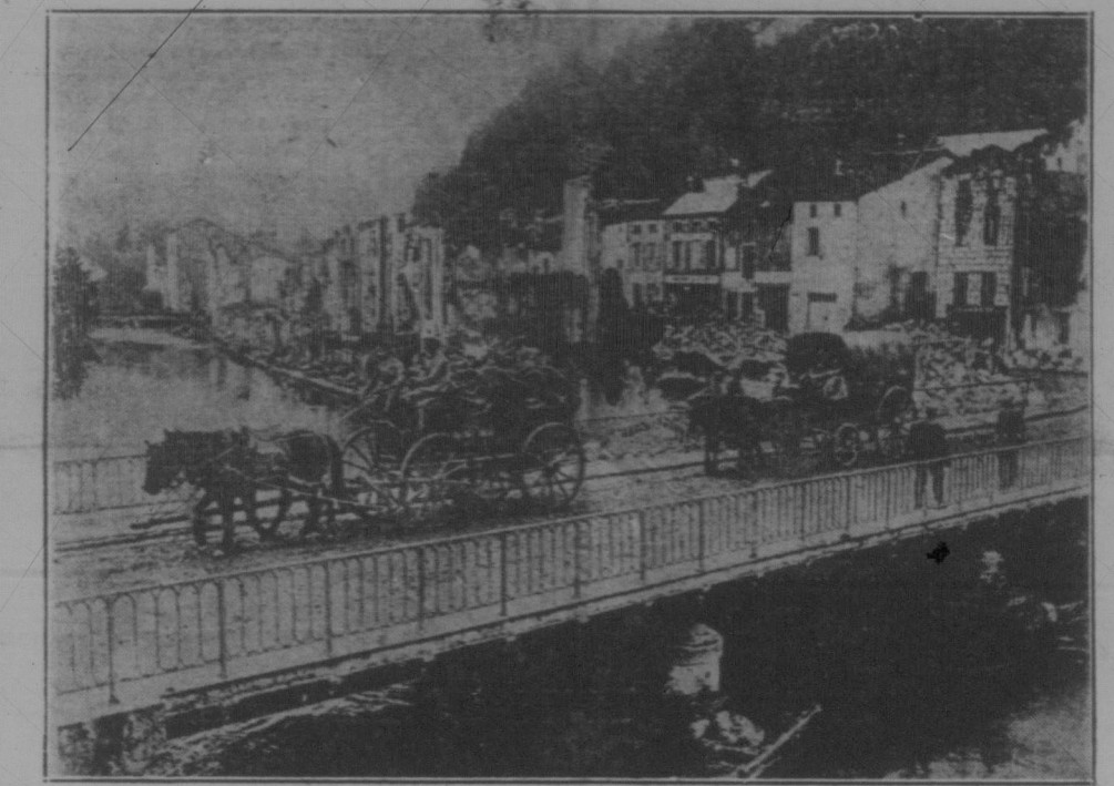
Dun an der Maas. Zerhödete Häuser an der Brücke über den Maas-Kanal.
