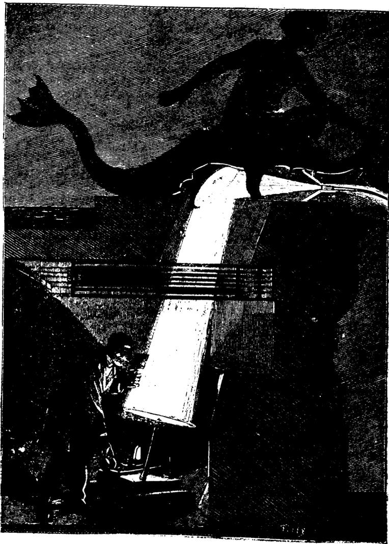
Fig. 2. — Disposition des projecteurs électriques éclairant les jets horizontaux.
