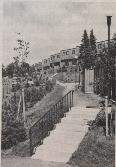
Eigentumswohnungskomplex in Halifax (Neuschottland), der durch das NHA finanziert wurde
