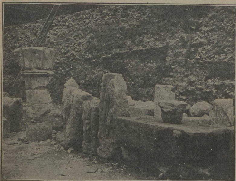
EN FRANCE—Ruines romaines découvertes à Paris, au cours des travaux souterrains du Métropolitain.
