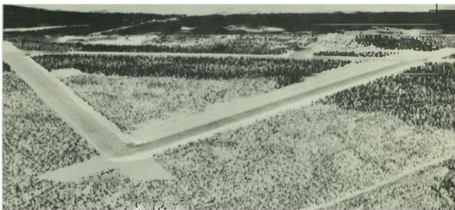
Construction de l'aéroport de Goose Bay. Mars 1942.
