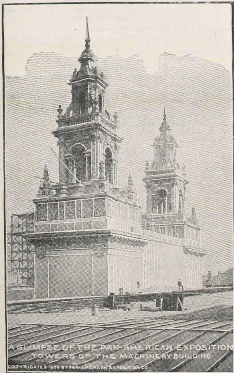
TOURS DU PALAIS DES MACHINES.
