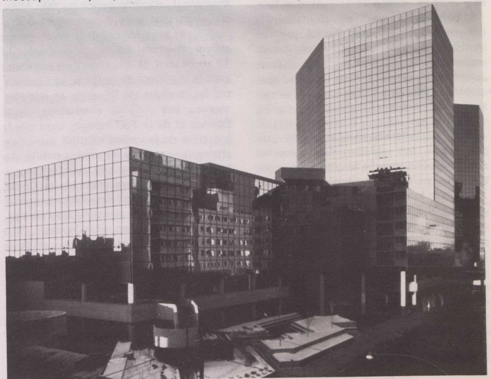
Le Gulf Canada Square est l'un des attraits du centre-ville de Calgary, en Alberta. C'est l'immeuble dont le rendement thermique est le plus élevé au monde.
