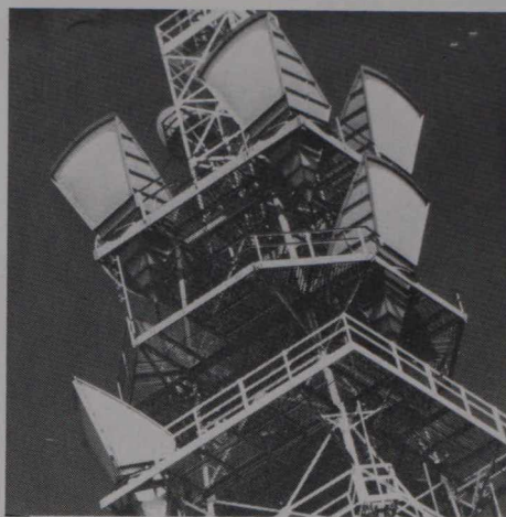
Microgolf zendmasten, waarvan hier het bovenste gedeelte met verschillende antennes, maken deel uit van het Canadese telecommunicatienet.
