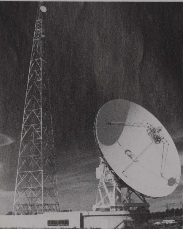
Een ontvangbasis met grote capaciteit in Ontario. De basis is eigendom van Telesat Canada en beschikt over een microgolf zendmast.
