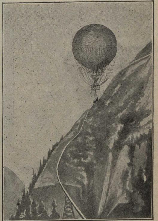
deux doubles lignes de rails en fer reposant sur des échafaudages en bois. Des roulettes rouleraient sur les rails. Un ballon serait attaché à l'essieu des roulettes, et au-dessous des rails serait la nacelle avec les voyageurs et les bagages. Pour la descente, il suffirait d'augmenter le poids de la nacelle par de l'eau.
