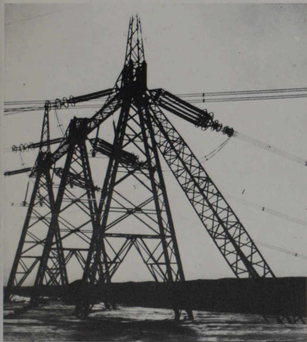
Torres de transmissão nas cataratas Churchill — Torres de transmissão nas Cataratas Churchill em Labrador. Uma das mais importantes usinas geradoras de energia hidrelétrica. Estas torres estão ancoradas em uma queda turbulenta de 1.828 m que corta os geradores da usina. A construção da torre é um dos exemplos obtidos pela engenharia energética que levou o país a uma excelente reputação mundial neste campo.
