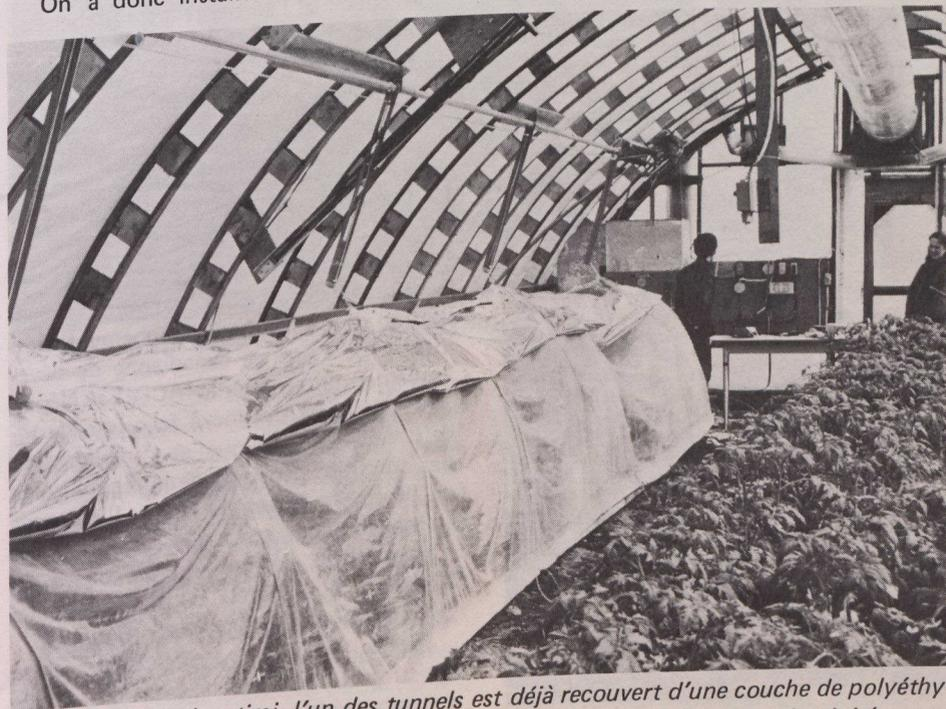
A la serre de Chicoutimi, l'un des tunnels est déjà recouvert d'une couche de polyéthylène transparent et on s'apprête à le recouvrir mécaniquement du mylar aluminisé.
