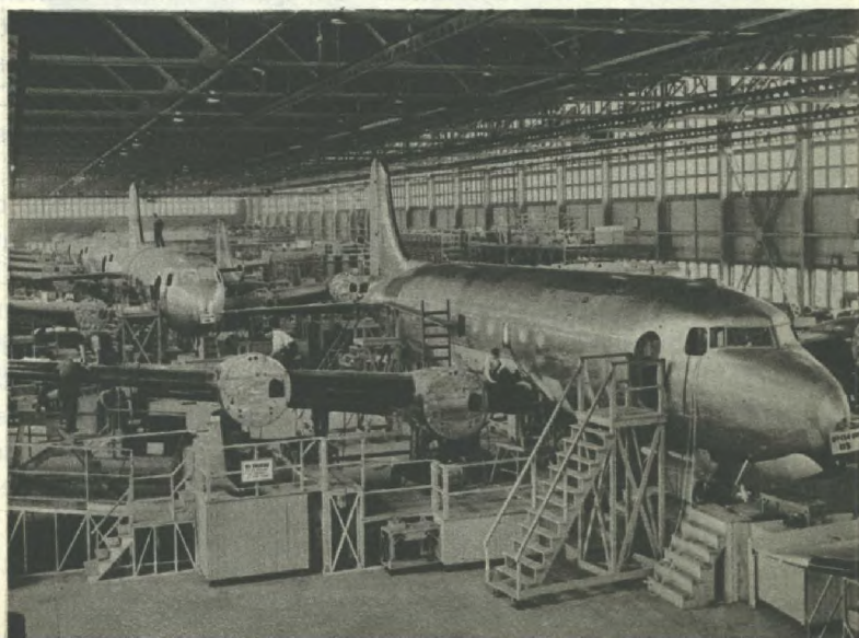
Un avion canadien North Star en voie de construction.
