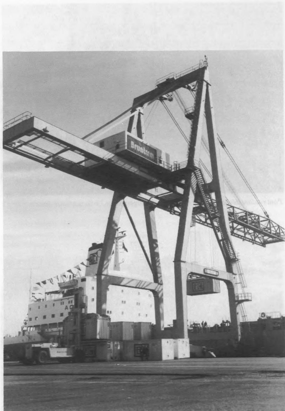
Grue de quai de type courant.
