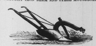
50 CAST IRON BEAM AND STEEL MOULDBOARD. 25 CAST IRON BEAM AND STEEL MOULDBOARD AND END
