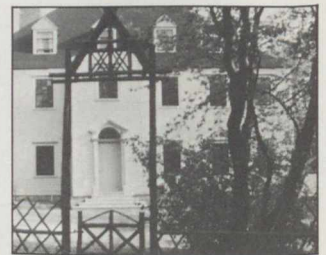
La maison du commissariat
