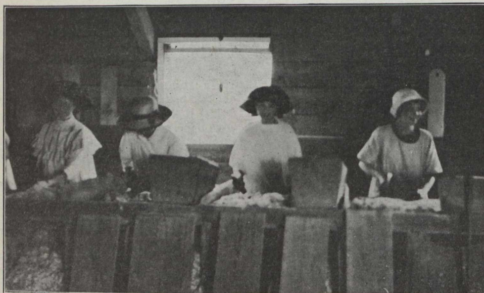
Cobbing Asbestos, Black Lake, P.Q.
