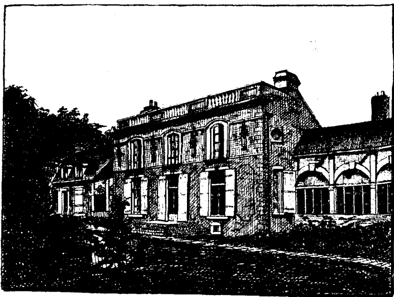
LE CHATEAU DE COLLIER. —Façade donnant sur la Loire.
