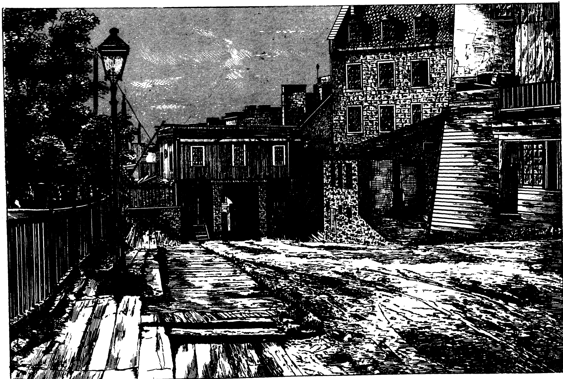
LA PORTE PRESCOTT, QUEBEC, RÉCEMMENT DÉMOLIE.
