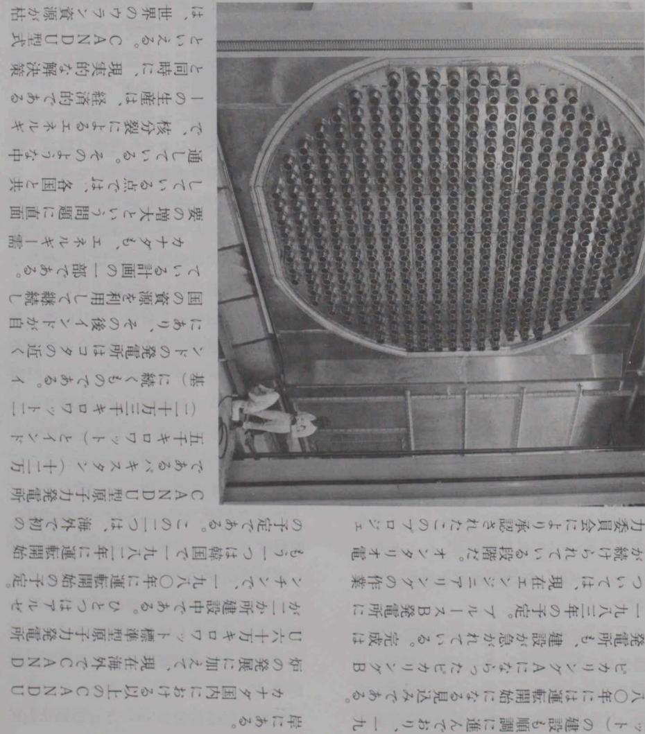
その他の圧力管には、12個の核燃料束が入っている。
