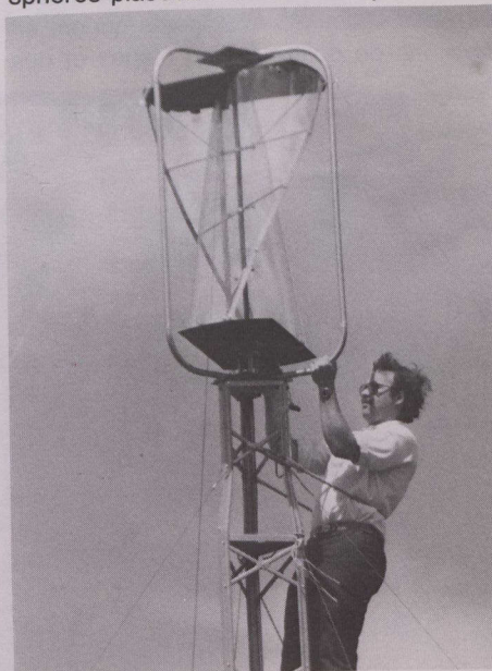
Le rotor Helius à axe vertical présente l'avantage de pouvoir fonctionner longtemps sans exiger de contrôles fréquents, quelle que soit la force des vents ou leur direction.
