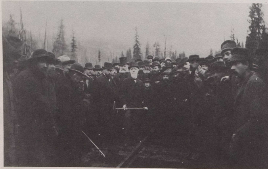
Donald Smith enfonce le dernier crampon de la nouvelle voie ferrée.
