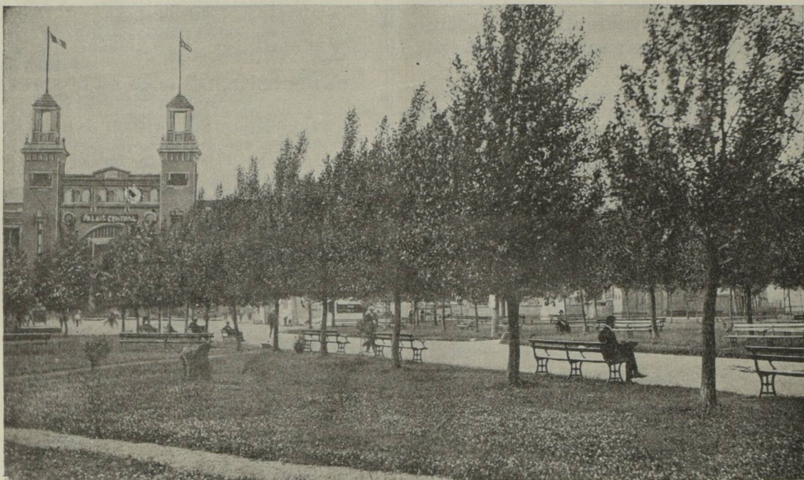
Une perspective touffue ombrageant l'une des avenues du Parc de l'Exposition de Québec, qui conduit à la grande plaza dont l'étendue permet de grouper 50,000 personnes et limitée à l'est par l'immense palais de l'Industrie et au nord par la majestueuse façade du Palais Central.
