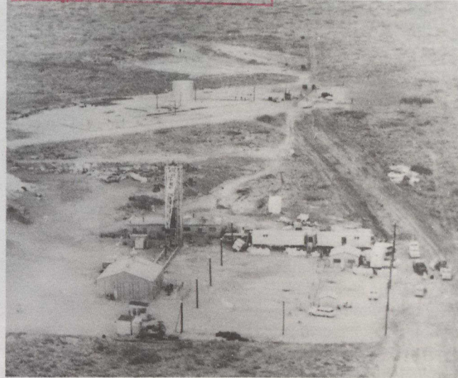
Préparation de la surface en vue d'un essai nucléaire souterrain dans une installation du Nevada.
